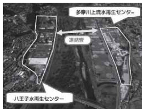
▲多摩川上流・八王子水再生センター間連絡管 (平成17年度完成)
