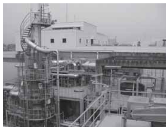
図表4-12 ターボ型流動焼却炉（浅川水再生センター）
