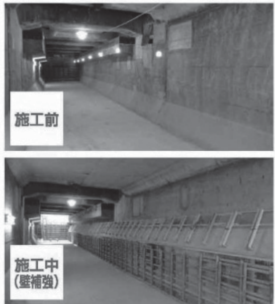
図表 4-15 耐震補強例（写真は施工中）
