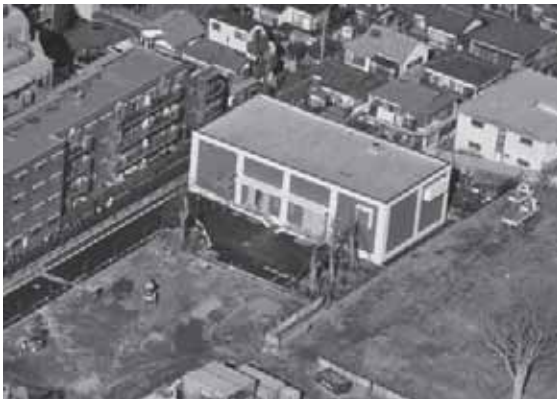
図表 4-21 野川下流部雨水貯留池
