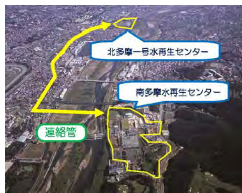
▲北多摩一号・南多摩水再生センター間連絡管 (平成24年度完成)
