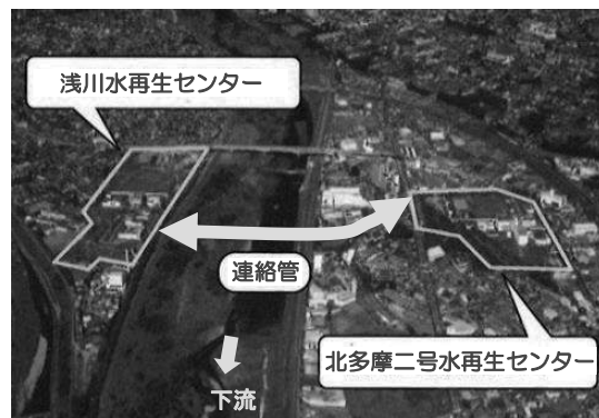
▲北多摩二水・浅川水再生センター間連絡管 (平成27年度完成)
