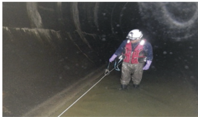
幹線の点検(北多摩二号幹線)
