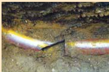
<破損した取付管を衝撃に強い硬質塩化ビニル製の取付管へ取替>
