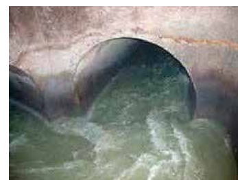
高水位の下水道管
