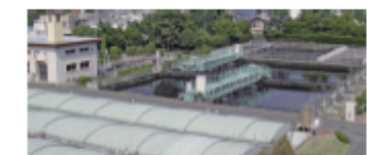
立川市錦町下水処理場(昭和42年稼働)
