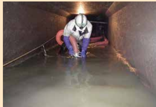
<管路内清掃の様子>
