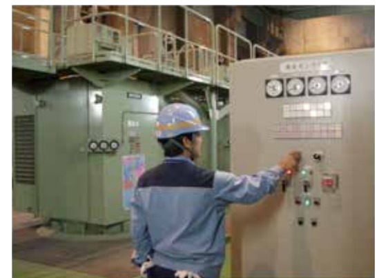
ポンプ設備の点検
