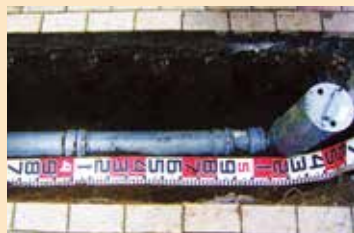
<破損した取付管を衝撃に強い硬質塩化ビニル製の取付管へ取替>
