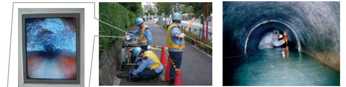
人力による下水道管内の調査
