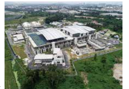
ランガット下水処理場▶
