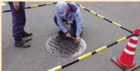
<マンホール蓋点検の様子>
