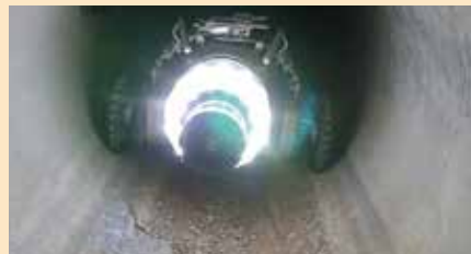
<管路内調査の様子>
