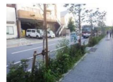
排水性舗装と道路植栽帯を組み合わせて、車道に振った雨を植栽帯に導き、雨水をより効果的に浸透させている（区画街路7号線）。
