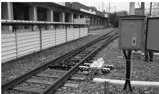
【模擬実習設備】
