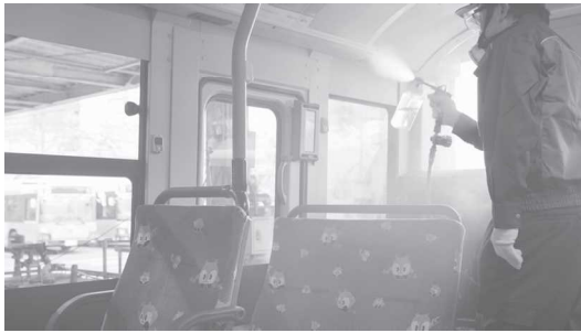
【抗ウイルスコーティング施工の様子】
