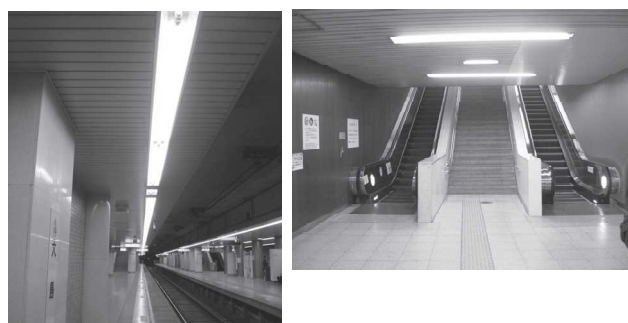
【照明のLED化・エスカレーターの改修・更新】
