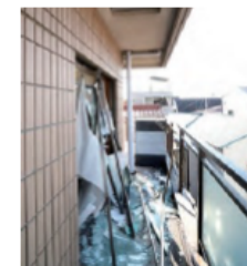
室内でストーブが原因となりスプレー缶内のガスに引火し爆発した火災（屋外バルコニーの様子）
